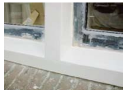
9. Alles weer als nieuw in de verf.
