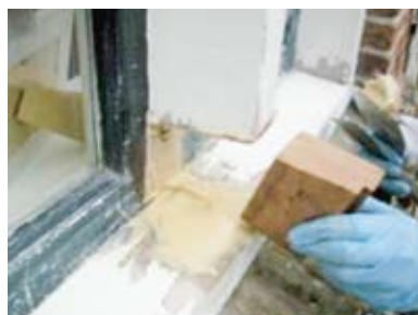
5. Gat gevuld met Repair Care en een houten klos op maat.
